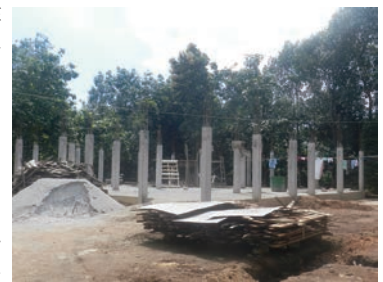
知的障がい者のための新たな建物の建設が2017年完成を目指して進められています
