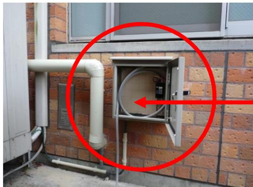
コードがボックス内に丸めて入っているのので、伸ばし、コンセントを発電機に差し込む。
