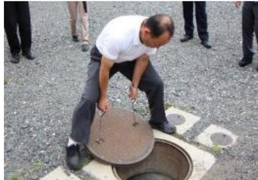
No4 マンホール内部：汚水が基準量になったら発電機を動かし送水ポンプを稼動して汚水を送水する
