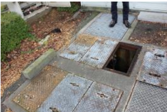
放流ポンプ(3層目)
