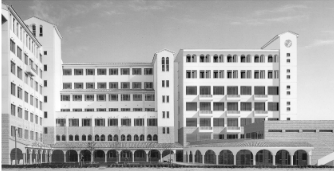
聖隷クリストファー看護大学2号館2001年11月竣工(右側建物)
