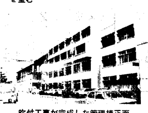
吹付工事が完成した管理棟正面
