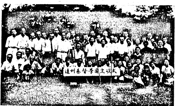
1946年(昭和21年)遠州基督教学園礎式挙行 聖隷保業園敷地内に校舎2棟建設、主に三方原開拓農村子女が入学し、普通教育及び農業技術教育を受ける。
